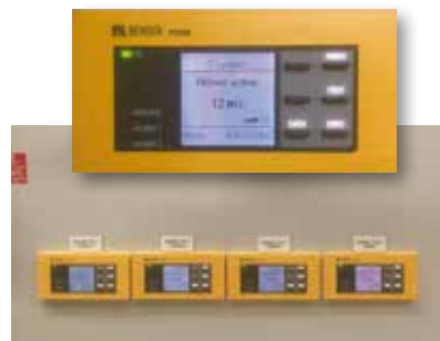
FP200 Anzeige- und Bedieneinheit für displaylose Geräte der Serie iso685
